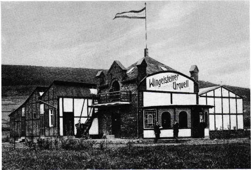
Abfüllanlage und Versandgebäude für den „Wingelsteiner Urquell“. Das Gebäude stand in den ehemaligen Bleichwiesen zwischen Dorf und Bundesstraße.
